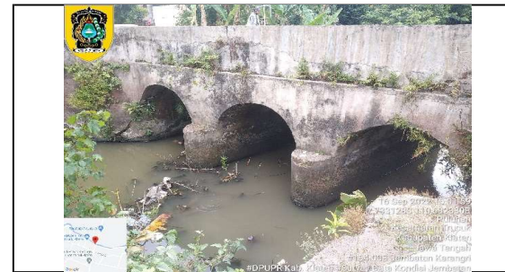
Foto jembatan arah hulu
