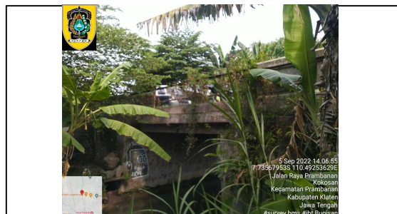
Foto jembatan arah hilir
